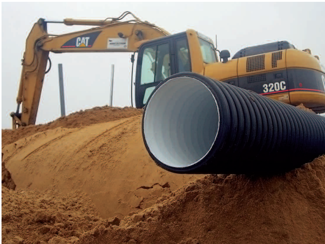
Рис. 1. Строительство трубопровода с применением труб КОРСИС
