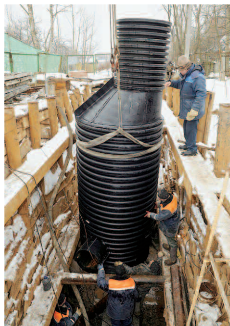
Рис. 27. Сварной прямопроходной колодец 1600 мм высотой 5,7 м
