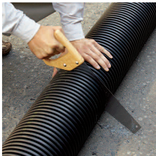
Рис. 18. Обрезка труб Корсис. Трубы КОРСИС отрезают перпендикулярно оси трубы по впадине гофра
