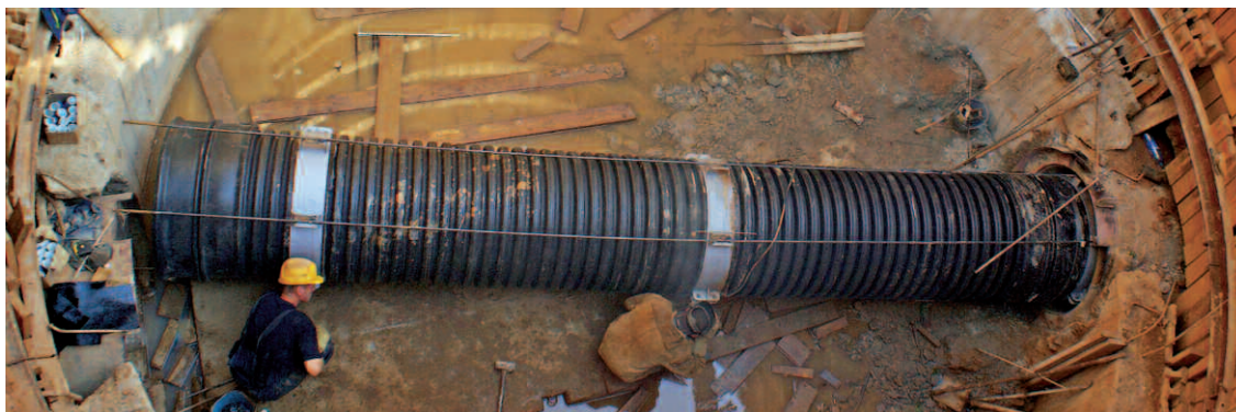
Рис. 19. Санация ж/б трубопровода с использованием трубы КОРСИС.
