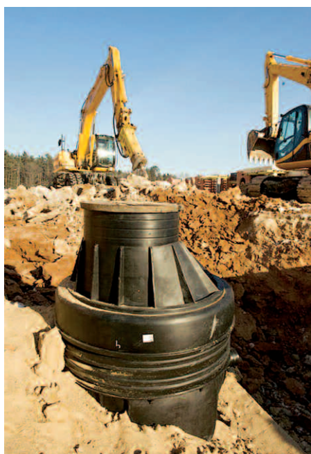
Рис. 26. Сборный колодец КОРСИС диаметром 1200 мм
