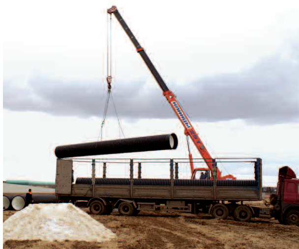
Рис. 38. Транспортировка труб КОРСИС
