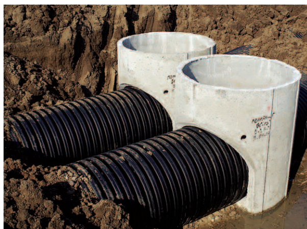
Рис. 30. Применение бетонных колодцев в системе труб КОРСИС
