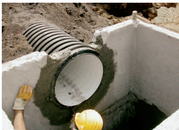
Рис. 29. Монтаж трубы КОРСИС в бетонном колодце
