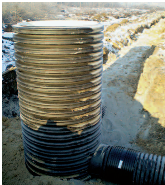
Рис. 28. Сварной угловой колодец Корсис
