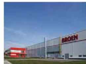
Производственный комплекс BROEN в Коломне
